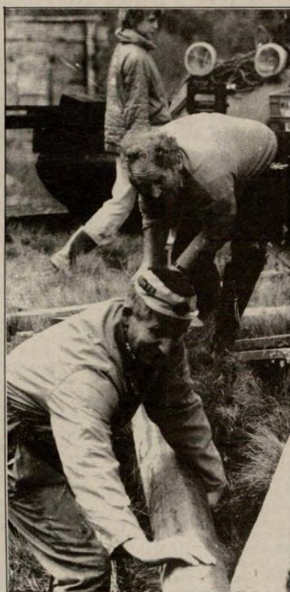
Kåre Edland og Olav Kvålen løfter brustokkane på plass
